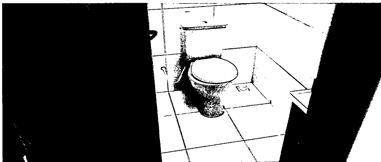
09. Imagem do WC 02 a reformar.
